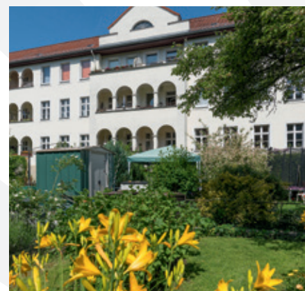
Gartenansicht Mehrfamilienhaus heute
