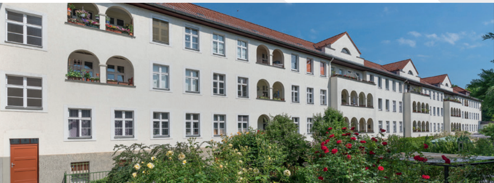
Gartenansicht Mehrfamilienhaus Planetenstraße Ecke Sonnenallee heute
