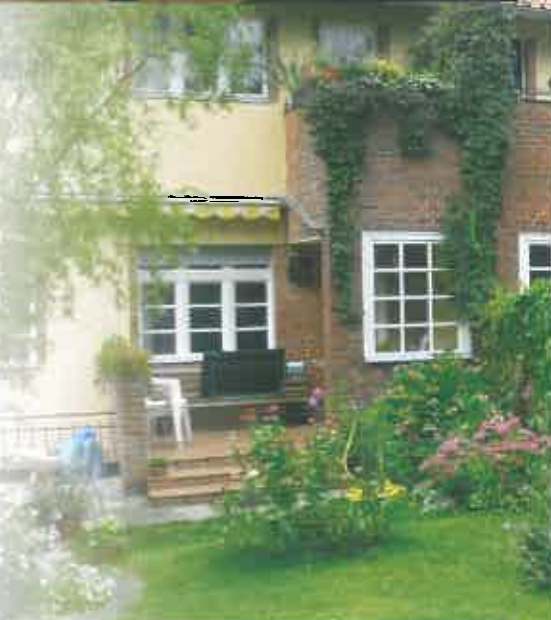
Neu gestaltete Terrasse des Laubenganghauses
