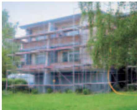
Fassadeninstandsetzung in Mariendorf
