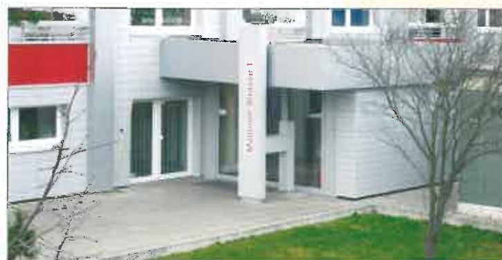
Neu gestalteter Eingangsbereich in der Mellener Straße, Block 27, Lichtenrade
