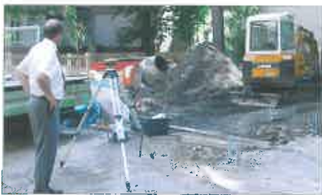
Arbeiten im Hof der Sonnenallee – ausgeführt von der Fa. Schniebe
