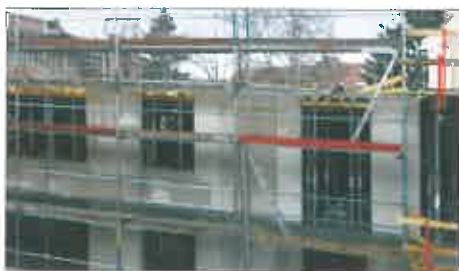
Neubau Spinozastr. 5 – Der Rohbau mit der Firma Bleck&Söhne
