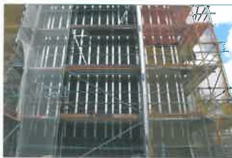
Mellener Str. 1 - Die neue energetisch hochwertige Fassade (Ausführung Henke AG)
