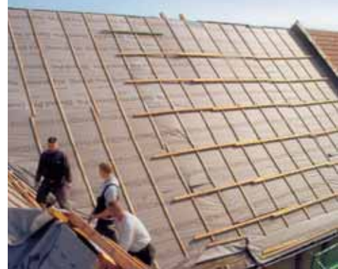
Dachinstandsetzung in der Sonnenallee
