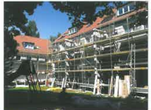
Die Hoffassade in Dahlem während der Arbeiten
